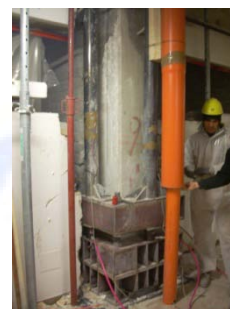
Messa in sicurezza e scarico del pilastro soggetto a scarnificazione, mediante martinetti idraulici.
