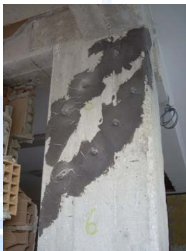
Ripristino delle fessurazione dei pilastri tramite iniezione con resine epossidiche.
