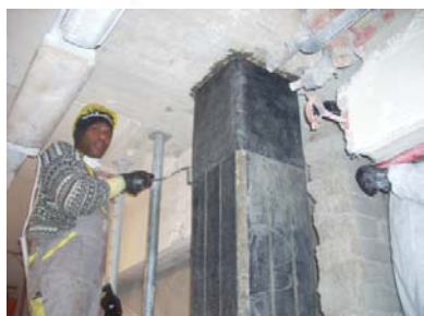
Fasciatura del pilastro mediante tessuti in fibra di carbonio opportunamente impregnati in situ.
