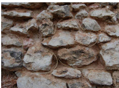
Inserimento del trefolo in fibra di acciaio uhtss FIDSTEEL 3X2-G all'interno del giunto di malta.
