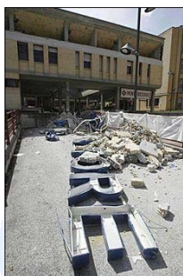
Facciata del pronto soccorso dell'ospedale San Salvatore a L'Aquila.
