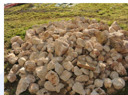
Materiale di recupero dopo il crollo.
