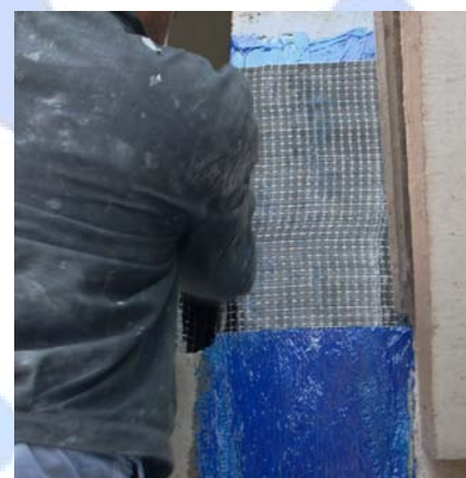
Fasciatura del pilastro tramite tessuto in fibra di carbonio FIDCARBON UNIDIR 300 HS 240.
