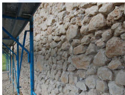
Pulizia e rimozione del giunto di malta per poter inserire il rinforzo e successiva ristilatura.
