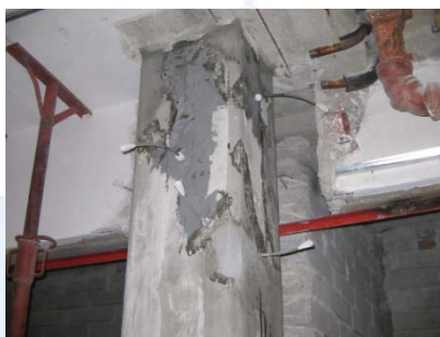
Cannule per l'iniezione delle fessurazioni mediante resine epossidiche fluide.
