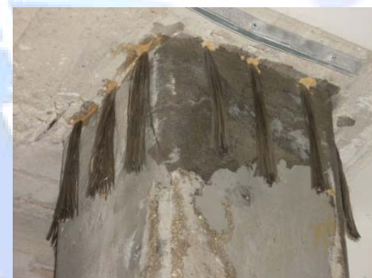
Perforazione per l'inserimento di barre a fiocco FIDBASALT CONNECTOR MONO-THREAD.
